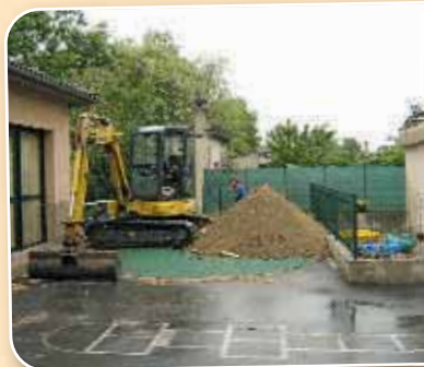
Changement et mise en place de la cuve propane à Longuegineste
